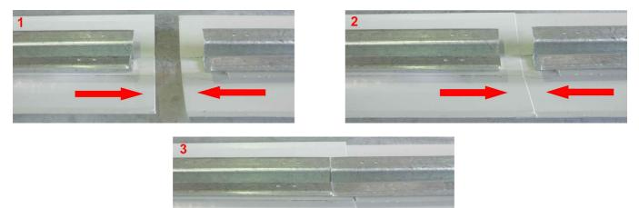
**STAGE 2:** INSERT RIDGE CAP JOINER INTO CONNECTED RIDGE CAPS. MAKE SURE JOINER HAS 225mm IN EACH RIDGE CAP.
