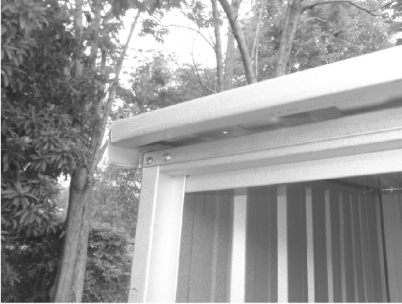
CORNER DOOR JAMB ASSEMBLY
