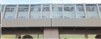
HIGH WATER BARRIER - MEDIUM VAPOUR BARRIER
